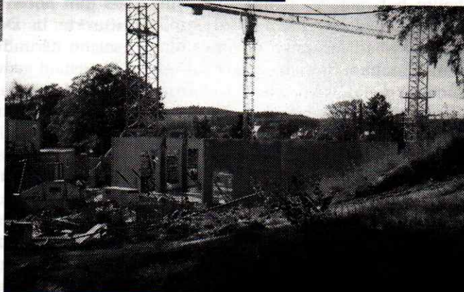
Foto rechts: Der begonnene Rohbau der neuen Klinik am Schillergarten.
